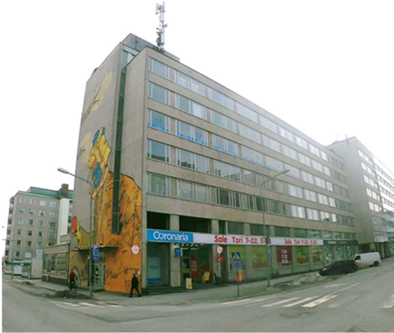
Kuva 1. Nykyinen rakennus, Valtakadun ja Yrjönkadun julkisivut
